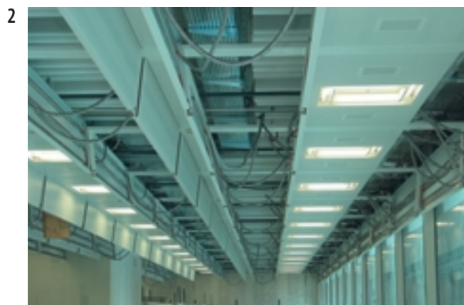
Bild 3 Das Prinzip der Raumboxen, hier in der Variante mit digitaler Kommunikation von Zonenantrieben, Lüftung über den MP-Bus von Belimo und Einbindung von Funktastern.
